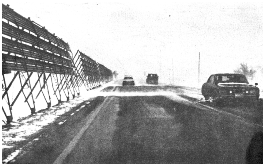
شکل ۳-۴- حصار برف‌زدکن چند رشته که در شانه راه نصب شده است.
