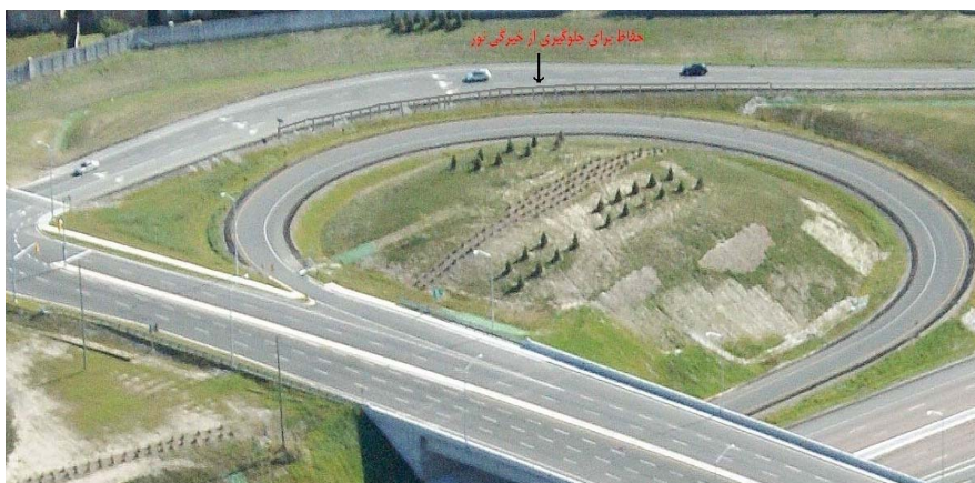
شکل ۳-۳۶- نصب حفاظ برای جلوگیری از خیرگی نور
